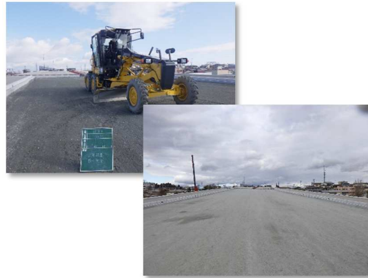
上層路盤工施工状況
