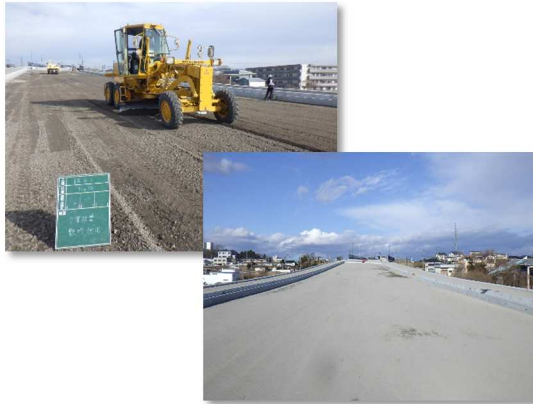
下層路盤工施工状況
