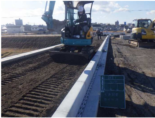
歩道路盤工施工状況
