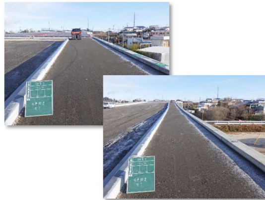
歩道路盤工施工状況
