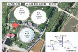
河内配水場全景
