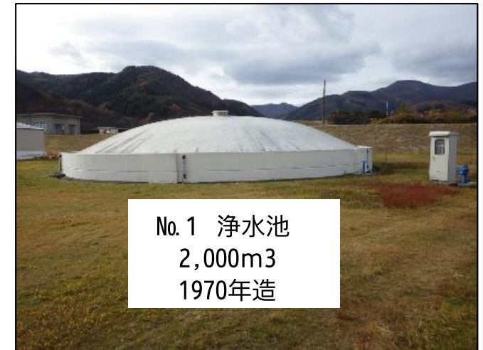
【現況No. 1 浄水池】
