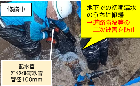
漏水修繕状況（管路深さ1.2m）
