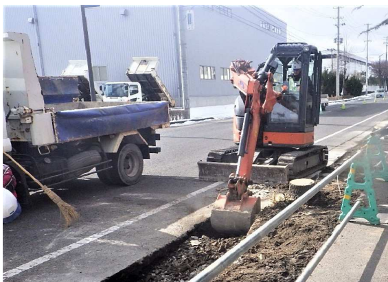
歩車道境界ブロック撤去状況
