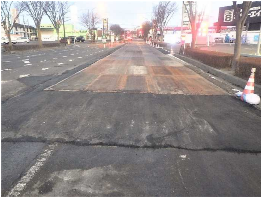
覆工板設置完了
