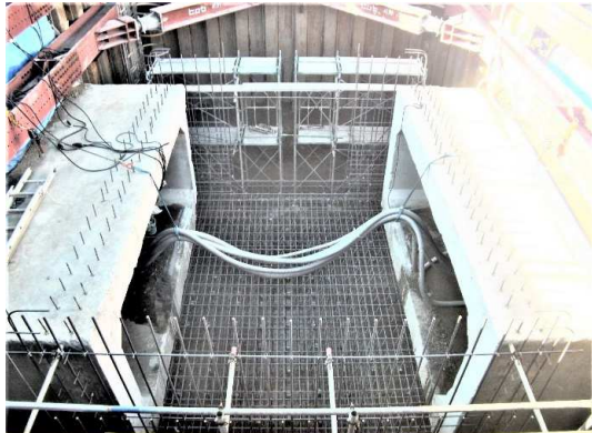
底版部鉄筋組立完了
