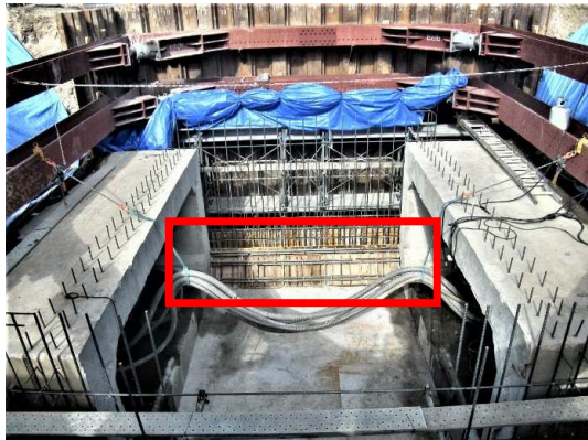
下部ハンチ型枠組立完了
