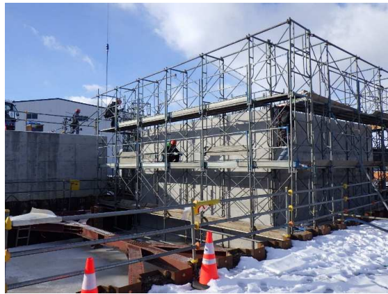
足場解体状況
