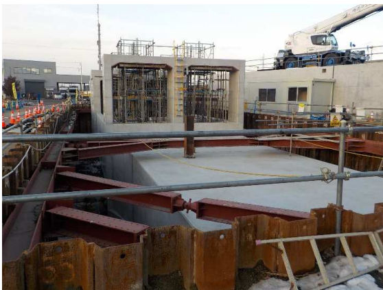
ポンプ槽完了
