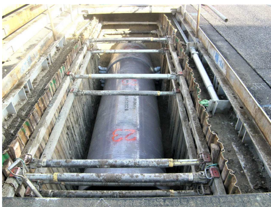
新設管布設完了
