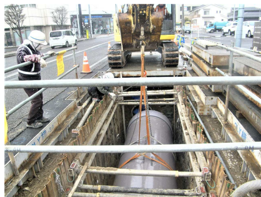
新設管布設状況
