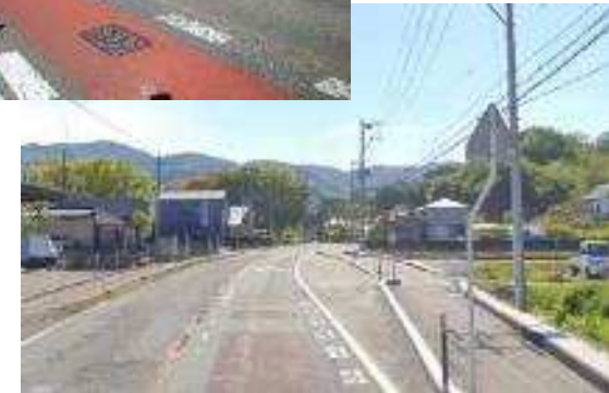
令和元年度施工
