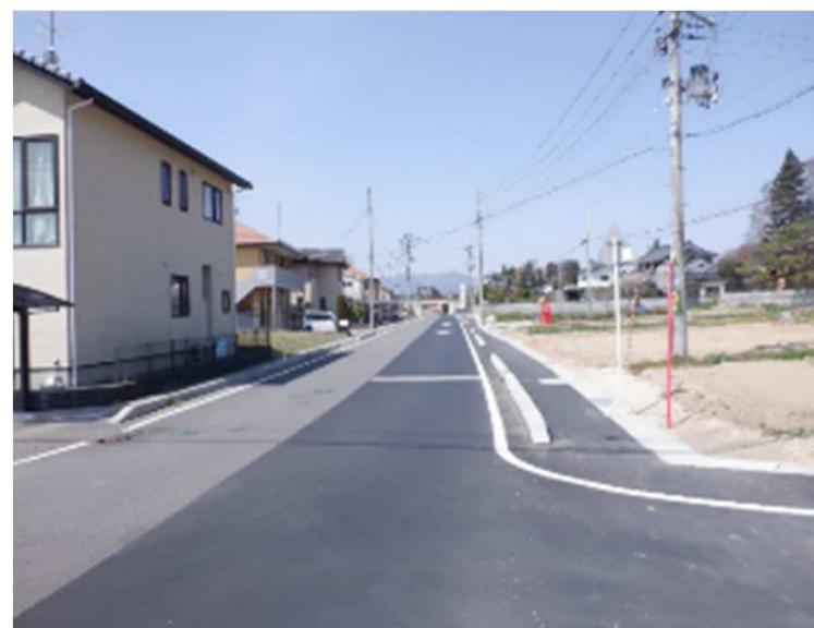
令和4年度施工
