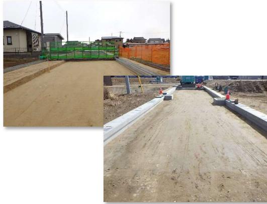
排水構造物(U型側溝)工及び路床工施工状況
