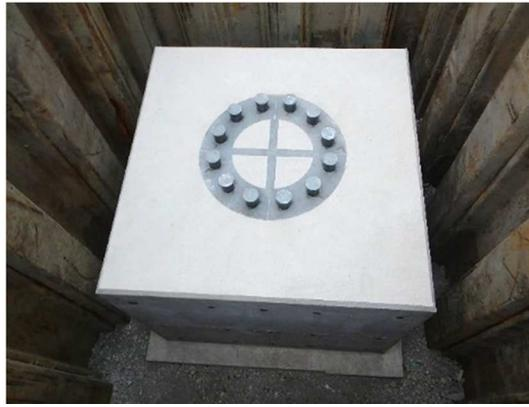
フーチング基礎工(コンクリート脱型完了)施工状況(S-KP2)
