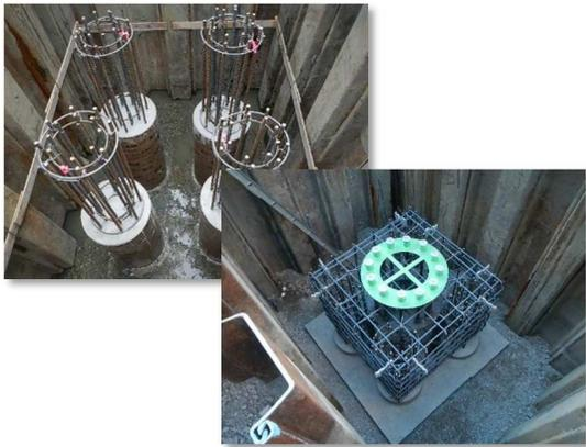
フーチング基礎工(鉄筋組立完了)施工状況(S-KP2)
