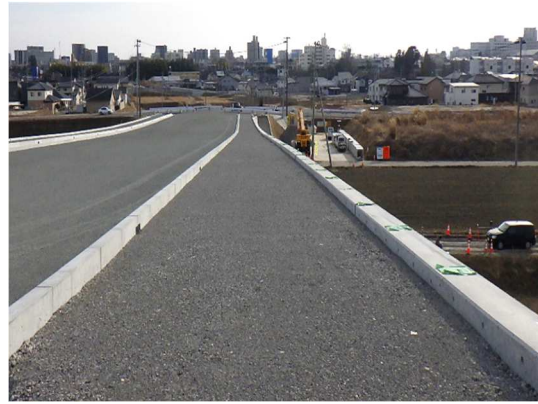
西側歩道路盤工施工完了(南側を望む)
