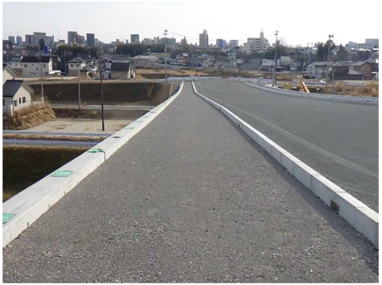
東側歩道路盤工施工完了(南側を望む)
