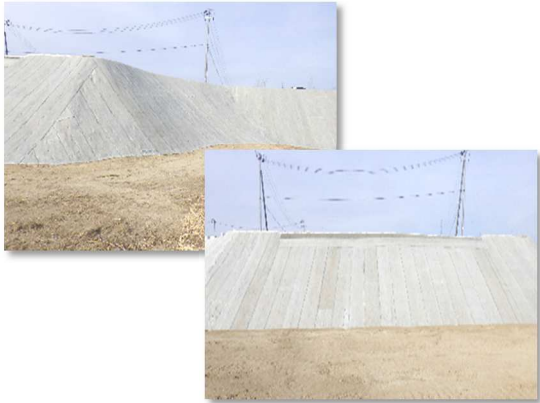
法面保護用植生シート設置完了(北側を望む)
