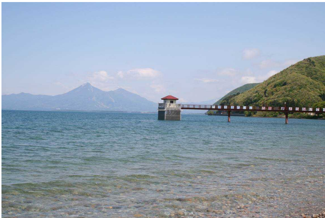
猪苗代湖と浜路取水塔
