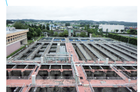
③雨水沈でん池 ④塩素混和池 ⑤雨水貯留池
