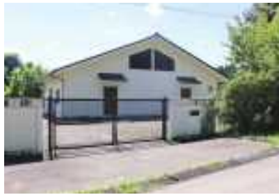
小川地区農業集落排水処理施設
