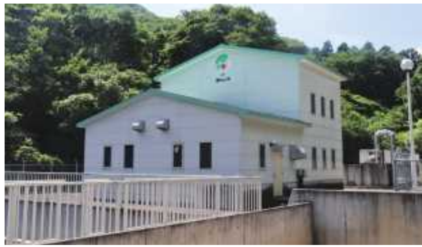
高濁度処理施設(深沢川取水場)
