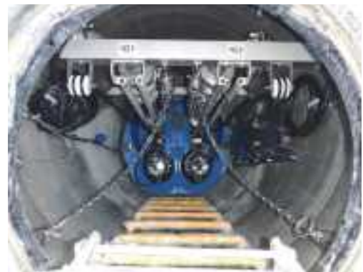
マンホール内部
