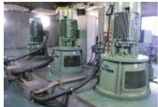
行合橋中継ポンプ場 汚水ポンプ ポンプの働きにより汚水をくみ上げて県中浄化センターなどへ送ります。
