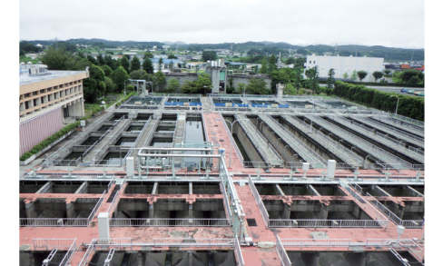
③雨水沈殿池 ④塩素混和池 ⑤雨水貯留池
