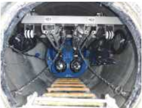
マンホール内部
