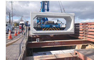
133号雨水幹線工事(字石塚)
