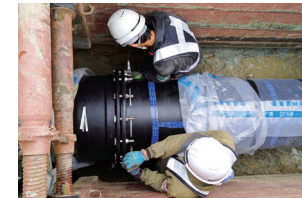
市内各所で地震に強い水道管への取り替えを進めています
