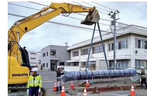
市内各所で地震に強い水道管への取り替えを進めています
