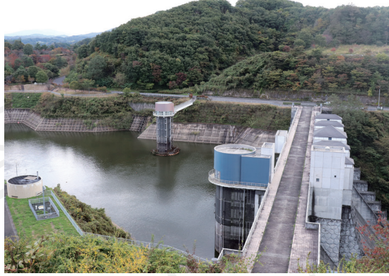
三春ダム(三春ダム取水塔)
