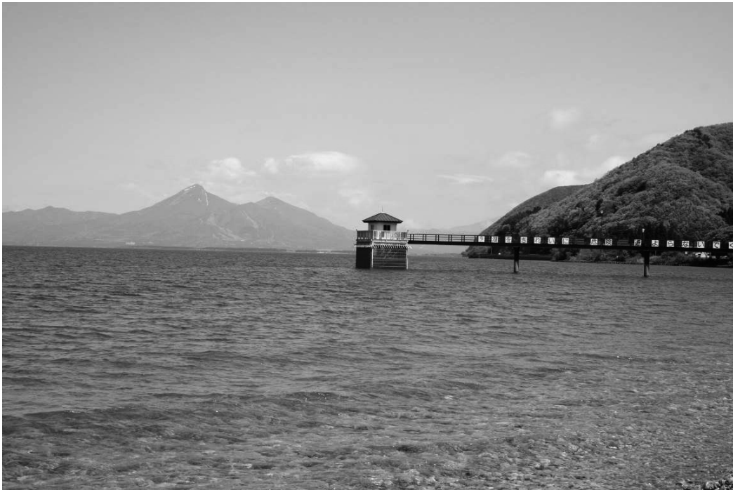
猪苗代湖と浜路取水塔
