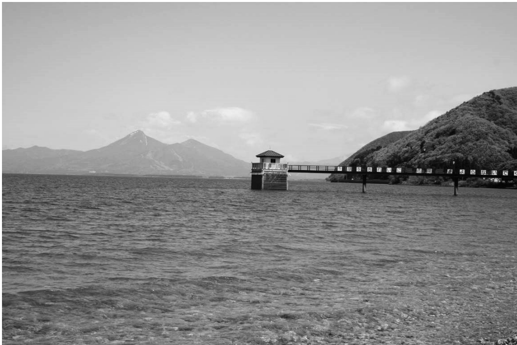
猪苗代湖と浜路取水塔
