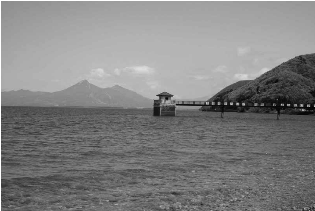
猪苗代湖と浜路取水塔
