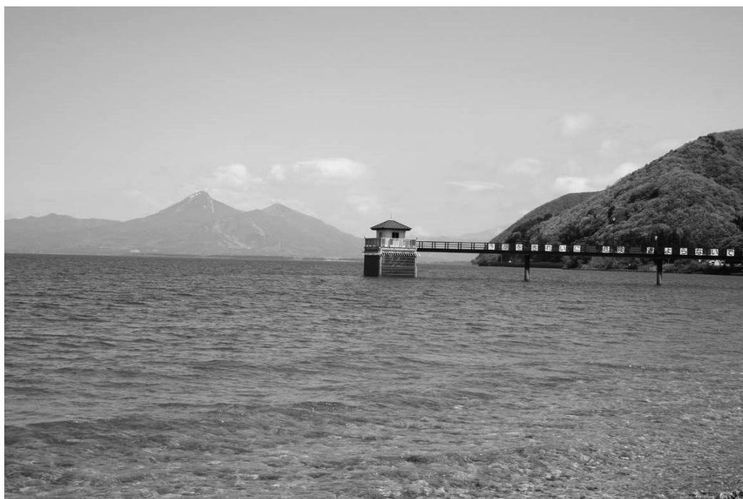
猪苗代湖と浜路取水塔
