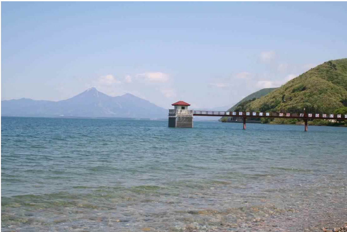
猪苗代湖と浜路取水塔
