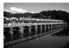
〔安積疏水十六橋水門〕
