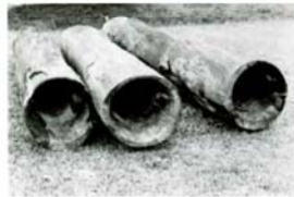
多田野水道木管
