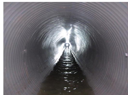
●下水道の長寿命化対策（管更正）
