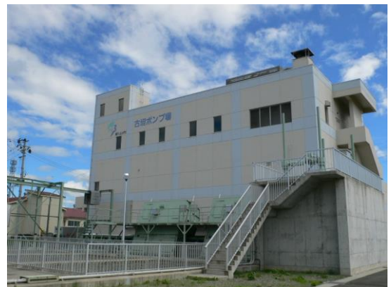
●古坦ポンプ場
