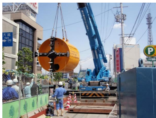
●雨水管の整備
