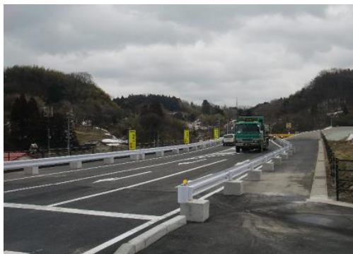
● 県道小野郡山線の整備
