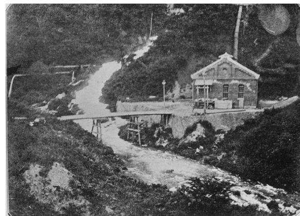
●沼上発電所（明治32年）
