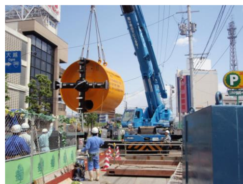
●雨水管の整備
