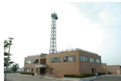
●古坦ポンプ場
