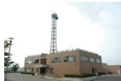
●古坦ポンプ場
