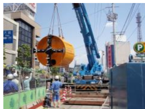
●雨水管の整備
