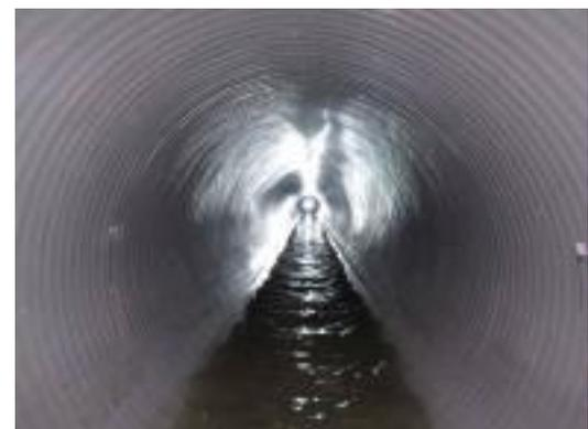
●下水道の長寿命化対策（管更正）
